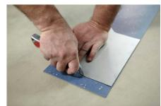
**9.** 去除地面上的衬纸,把材料长条整齐粘贴在已铺设的材料边。
