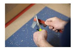
**6.** 把nora<sup>®</sup> profix 90安装胶带贴于 距离地板材料边缘至多空开2毫 米处,并来回推压固定。
