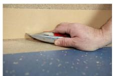
**5.** 切割垫高线,针对阴阳角使用型材剪刀斜切并粘连。
