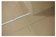
**2.** 铺放noraplan<sup>®</sup>并切割接缝部位。 准确按照标记涂抹粘合剂,在晾 胶后铺设材料。
