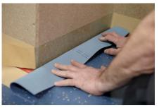
**10.**使用nora<sup>®</sup>模板斜切阳角处已粘贴的材料长条。
