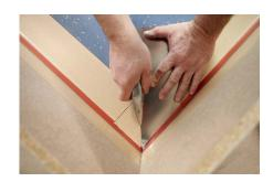
**8.** 剪裁覆盖基座部位所需的材料长条(19厘米宽)。
