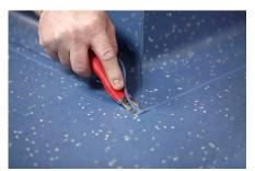
13.必须使用nora®l K冷焊剂对阴阳 角和接缝处进行填缝处理。在铺设完毕和使用nora®液体蜡打蜡 后可即刻进行冷焊(参见"焊接" 处理推荐)。
