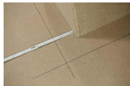
2. Extender noraplan<sup>®</sup> y cortar las costuras. Aplicar adhesivo exactamente hasta la marca y colocar el pavimento tras el tiempo de secado.
