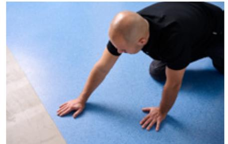
8. 然后使用软木板等工具仔细来回推压整个表面，随后使用50公斤的压辊在整个表面上进行纵向和横向滚动。取决于温度，必须在一定时间内（取决于现场温度）重复操作该过程。把翘起的边缘和角按平。在胶黏剂凝固之前对空鼓部位等施加重物压制。
