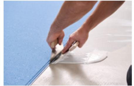
6. 胶黏剂所需的晾胶时间取决于基面的温度、湿度和吸收性。在此非常重要的一点是，不要让胶黏剂过度晾胶。确保材料背面有足够的胶黏剂转移。请注意胶黏剂制造商提供的补充信息。
