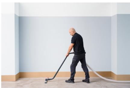
**2.** Dans la pratique, il est plus efficace d'étaler d'abord les dalles dans le local et de continuer en découpant les bords, les raccordements de porte, le pourtour des tuyaux... Le revêtement peut ainsi s'adapter à la température du support. Il faut veiller à ce qu'aucun résidu de production ne se dépose ni sur les surfaces encore à revêtir ni sur l'envers du revêtement.
