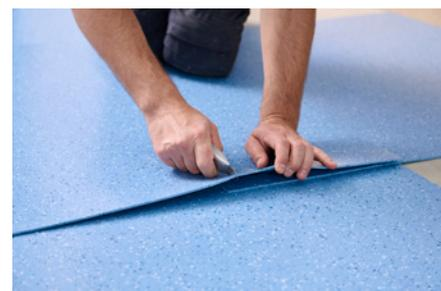
**3.** Les rangées de dalles sont ensuite rabattues et collées. Cette méthode a l'avantage de convertir les dalles posées en carreaux de butée pour les dalles à poser. Cela permet d'éviter que les joints soient décalés ou irréguliers.
