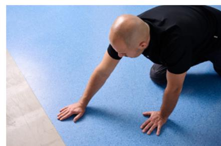
8. Par la suite maroufler le revêtement avec soin sur toute la surface, p. ex. avec une planche en liège, puis éventuellement rouler toute la surface - dans les deux sens - avec un rouleau marouffleur de 50 kg. Ce processus doit, selon la température, être répété après quelques temps. Rouler en sens inverse et appuyer sur les bords et coins relevés. Les cavités ou autres sont à lester jusqu'au durcissement de la colle.
