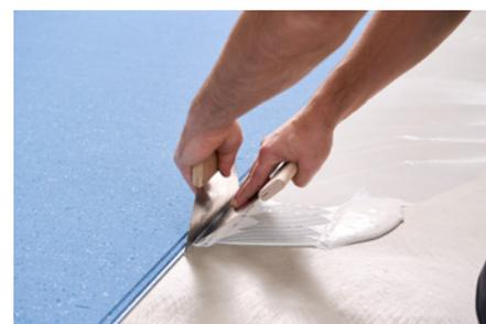
6. Le temps d'aération nécessaire dépend de la température, de l'humidité et du pouvoir absorbant du support concerné. Il faut donc veiller à ce que le temps d'ouverture de l'adhésif ne soit en aucun cas dépassé. Assurez-vous que l'adhésif a été correctement transféré à l'arrière du revêtement de sol. Veuillez tenir compte des informations supplémentaires fournies par le fabricant.
