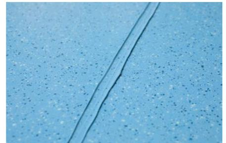
6. Die zur Seite gedrückte Fugenmasse kann nach ca. 12 Stunden entfernt werden.
