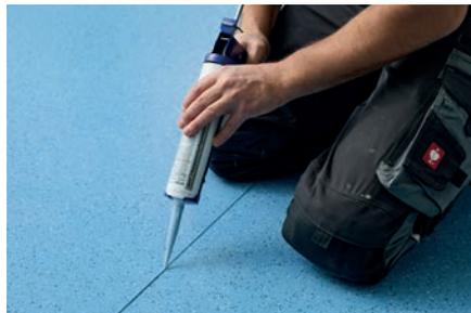
5. Die eingespritzte Fugenmasse wird unmittelbar nach dem Ausspritzen mit dem nora<sup>®</sup> Glättspatel in die Fuge gedrückt und eben abgezogen. Die überschüssige Fugenmasse wird dabei links und rechts neben die Fuge gedrückt. Es ist darauf zu achten, dass eine Trennung der Fugenmasse in der Fuge von dem zur Seite gedrängten Material erfolgt. Spatel möglichst flach halten, da sonst Hohlfugen entstehen.
