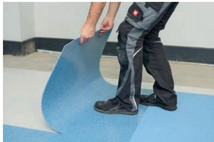
6. Schutzpapier von nora dryfix<sup>™</sup> ed entfernen und bis auf ca. 10 cm abschneiden. Diese 10 cm umklappen und unter den zurückgeschlagenen Belag schieben. Dadurch lässt sich verhindern, dass Schmutzpartikel in die Klebstoffschicht gelangen. Falls nora dryfix<sup>™</sup> ed durchgeschnitten wurde, bitte beide Teile mit einem Kupferband verbinden.
