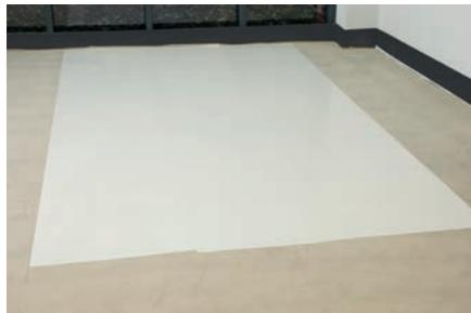
3. Die nora dryfix™ ed-Überlappungen im Nahtbereich entweder mit Hilfe eines Lineals an der unteren Kante entlang beschneiden oder mit Unterkantenschnitt bearbeiten. Dabei ist darauf zu achten, dass keine Fehlstellen breiter als 2 mm entstehen.
