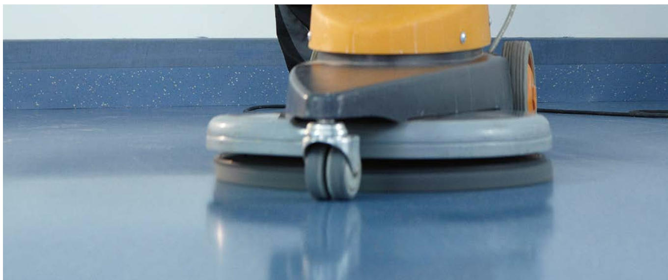
Acabado. Limpiar los revestimientos primero y luego pulir para obtener un acabado muy brillante
