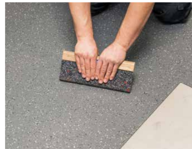
Gni gulvbelegget med en pussekloss av kork
