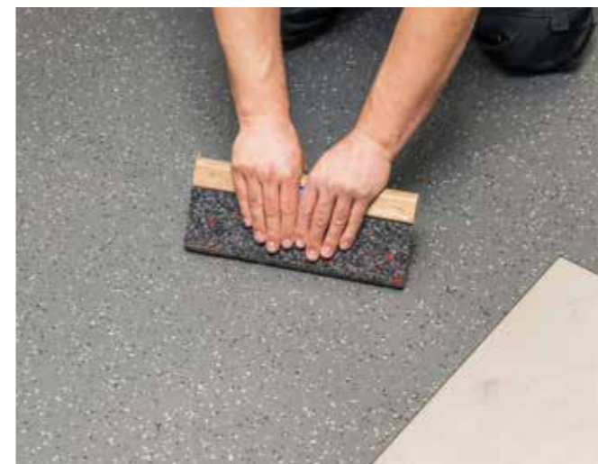
Wrijf de vloerbedekking aan met een kurk
