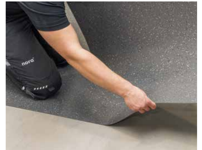
Leg de vloerbedekking als de antislip een transparante kleur heeft
