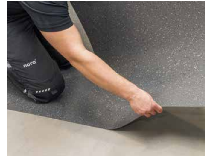
Poser le revêtement de sol
