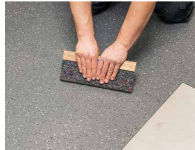
Bodenbelag mit Korkbrett anreiben.
