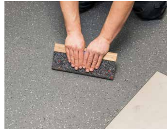
Gnub gulvbelægningen fast med en korkplade
