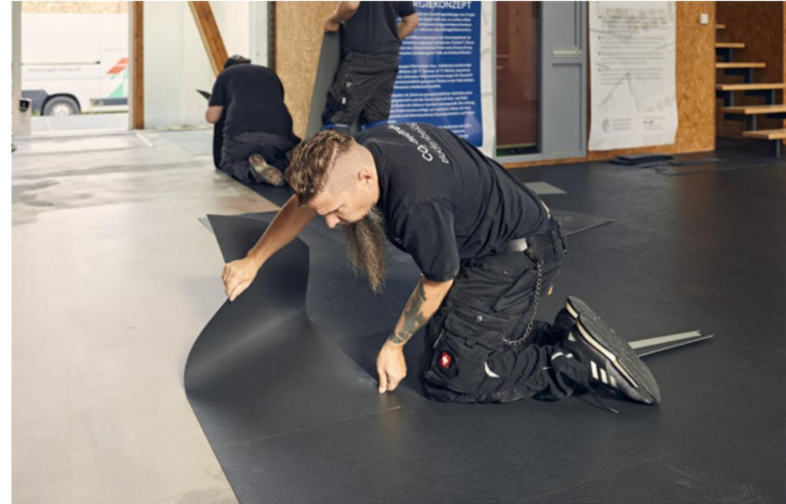
Die Fliesen werden nach der gewünschten Abtrocknung der Fixierung eingelegt. Anschließend wird der Belag vollflächig mit einem Korkbrett angerieben und mit einer 50 kg Eisenwalze angewalzt.
