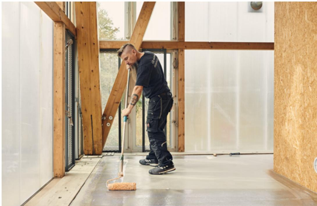
Vor der Verlegung wird eine geeignete Fixierung nach Herstellerangaben aufgebracht.
